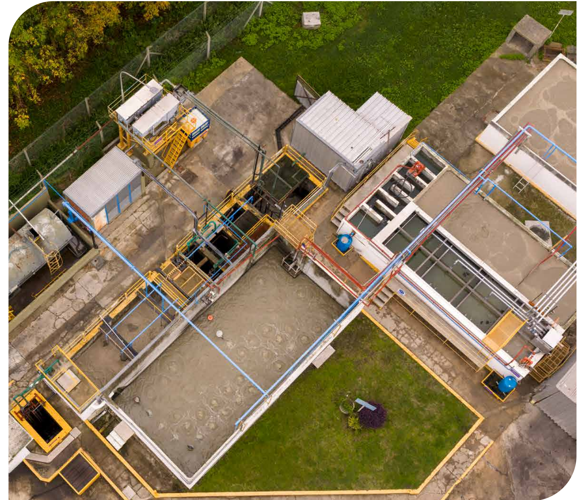
(59) Cámara Toma de Muestra
